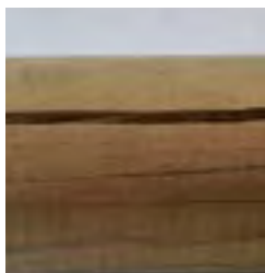
Cracks/Grietas/Fente/Risse/ Crepe/ Barsten/Fendas
